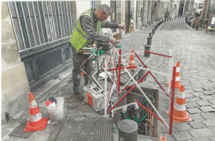
Installation de la fibre, à Bordeaux. L'activité du secteur est en forte croissance, dopée par l'objectif du Plan France Très Haut Débit, qui prévoit de couvrir 100% du territoire d'ici à 2022.
